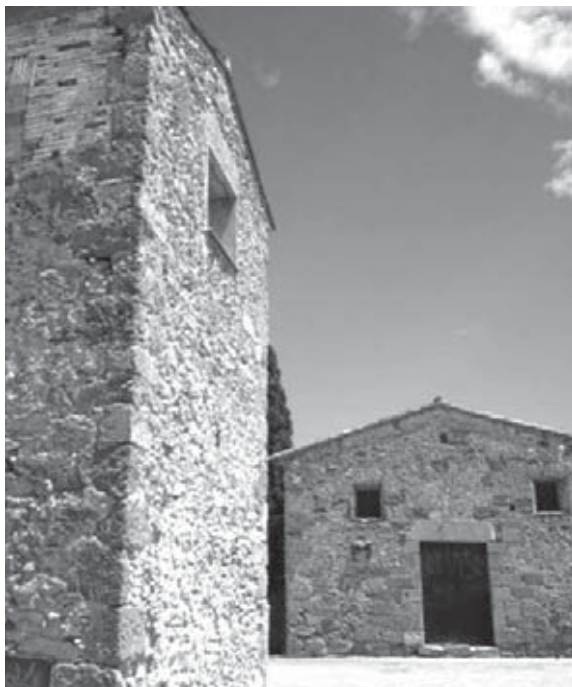
Figura 1. Façana de la Casa del Delme de Fortià, amb l'església de Sant Julià i Santa Basilissa en primer terme, a l'esquerra. (Autor: Pere Duran – Diputació de Girona).
